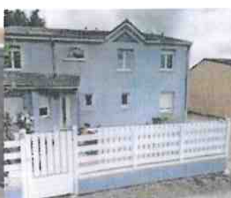
Clôture à claire-voie
